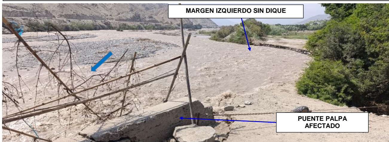
FIGURA N°02: RIO CHANCAY-HUARAL, SECTOR AGUAS ARRIBA DEL PUENTE PALPA CON EL CAUCE COLMATADO CON PRESENCIA DE VARIAS ISLAS DE SEDIMENTOS Y MARGEN IZQUIERDA DEL RIO SIN DIQUE POR SOCAVACION DEL CAUDAL.
