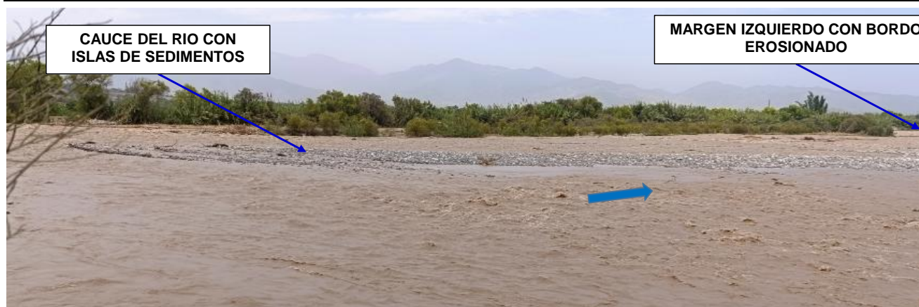
FIGURA N°01: TRAMO CRÍTICO EN EL RÍO CHANCAY-HUARAL, DIQUE DE MARGEN IZQUIERDO EROSIONADO, AGUAS ABAJO DE LA BOCATOMA CAQUI CRITICO Y EL CAUCE COLMATADO DE SEDIMENTOS.
