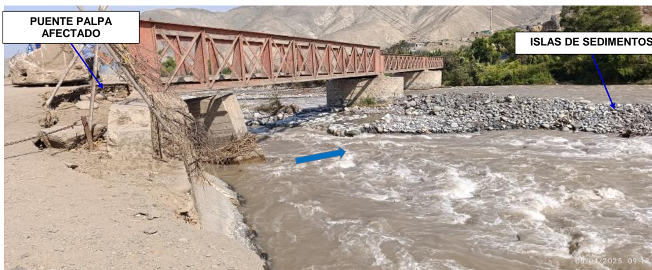
FIGURA N°04: RIO CHANCAY-HUARAL, ALTURA PUENTE PALPA AFECTADO POR EROSION, CAUCE COLMATADO CON ISLAS DE SEDIMENTOS CON RIESGO A SER AFECTADO LA PISTA HUARAL - PALPA.
