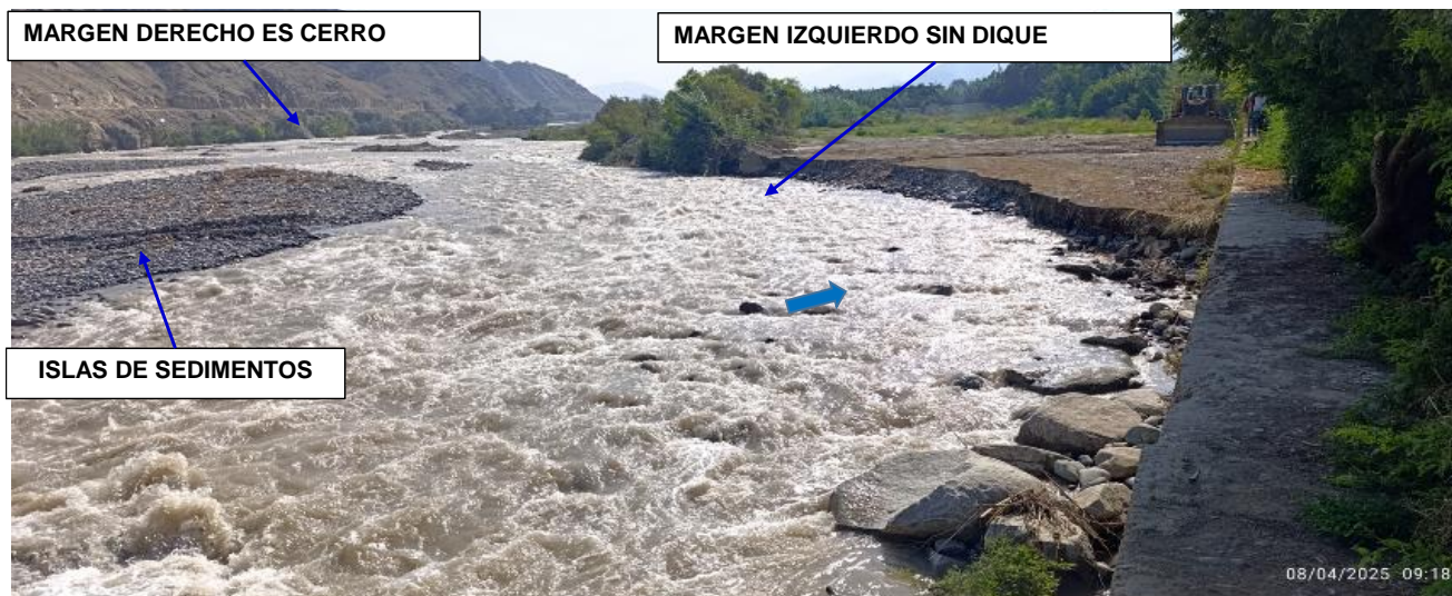
FIGURA N°03: RIO CHANCAY-HUARAL, CON EL CAUCE COLMATADO CON ISLAS DE SEDIMENTOS Y CON EL BORDE IZQUIERDO EROSIONADOS POR EL CAUDAL, TRAMO DE RIO CON RIESGO A DESBORDES QUE AFECTARIAS AREAS DE CULTIVOS.
